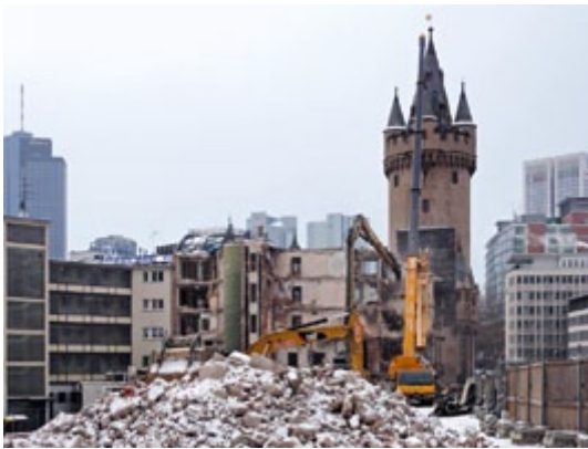
Harte Kontraste zwischen Alt und Neu am Eschenheimer Turm, Abriss des Turmpalastes 2013. Foto: Stadtkind Frankfurt, Roberto Zambotti
