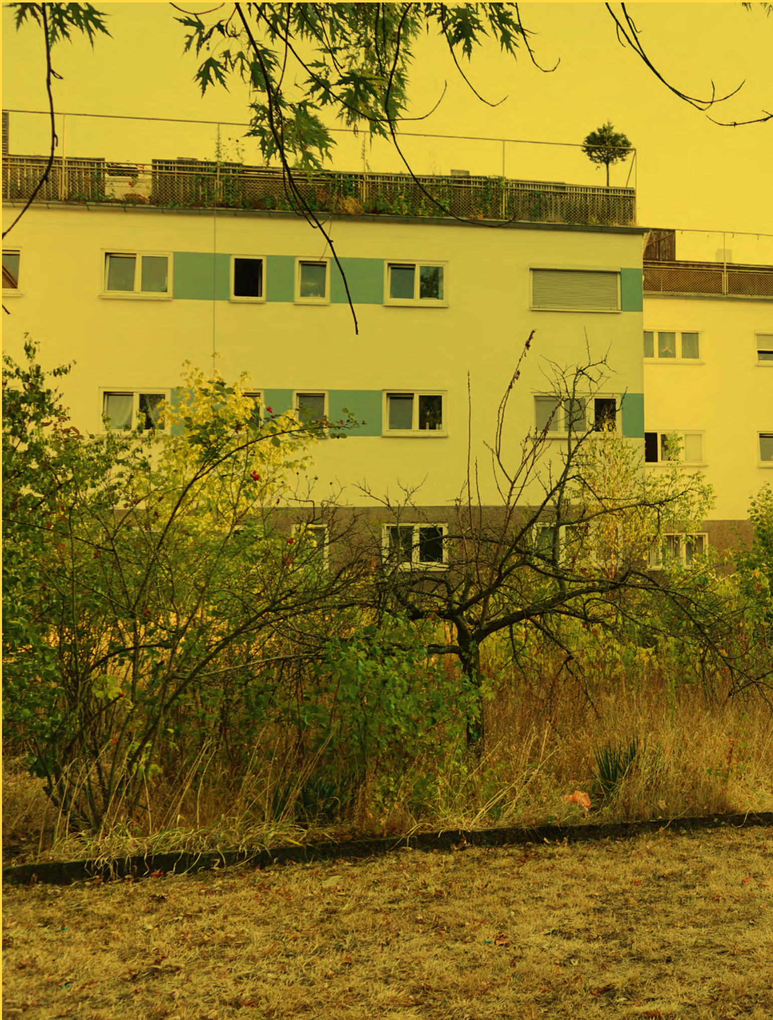
Häuser mit Dachterrassen und Innenhof mit Gartenparzellen
