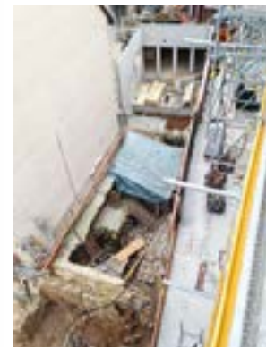
Aufdeckung von Resten der frühmittelalterlichen Mauer an der Nordseite des Stauferspalas. Foto: hmf, S. Gesser
